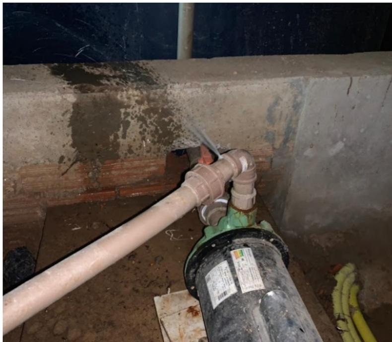
Figura 26 - Tubulação de saída da bomba de abastecimento de água rompido.
