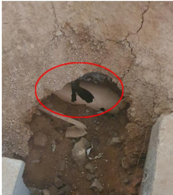
Figura 24 - Cano do trecho 1 do sistema de drenagem rompido no subsolo.
