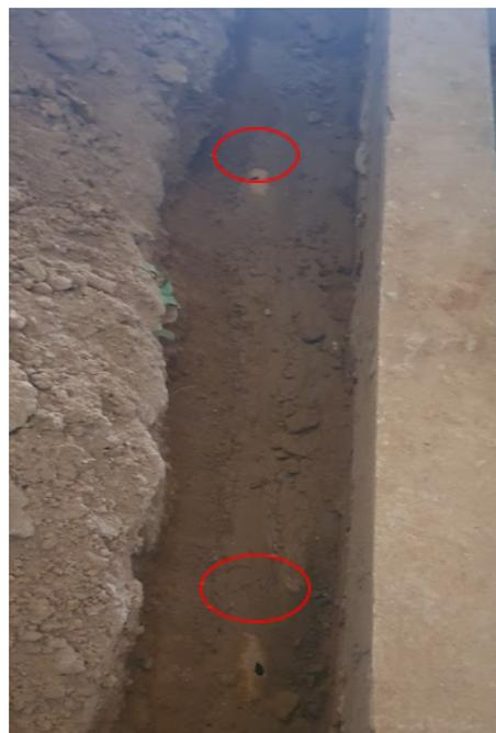
Figura 25 - Cano do trecho 2 do sistema de drenagem rompido no subsolo.
