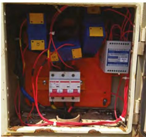
Figura 14. Instalação do medidor de energia em um quadro.
