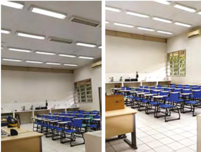
Figura 4. Antes (esquerda) e depois (direita) do retrofit da iluminação em um laboratório.
