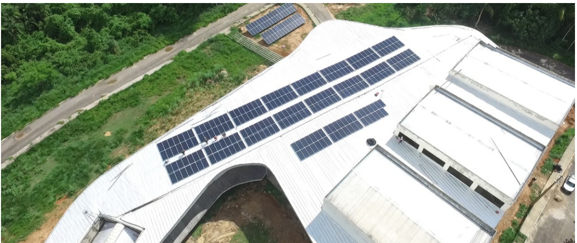
Figura 23: Planta fotovoltaica III, instalada no telhado do Ceeac
