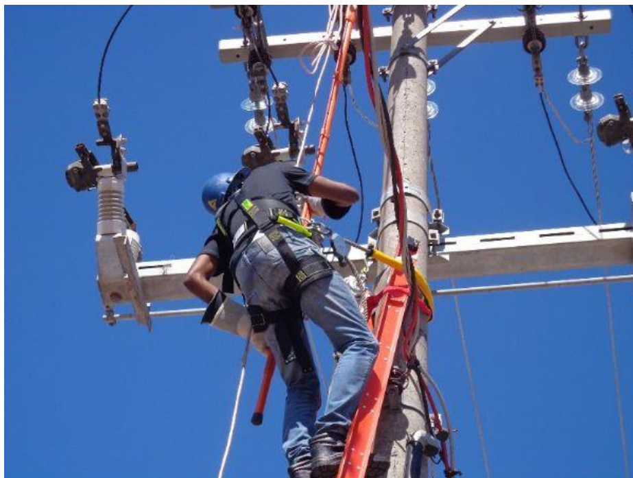
Figura 11: Rede MT em manutenção
