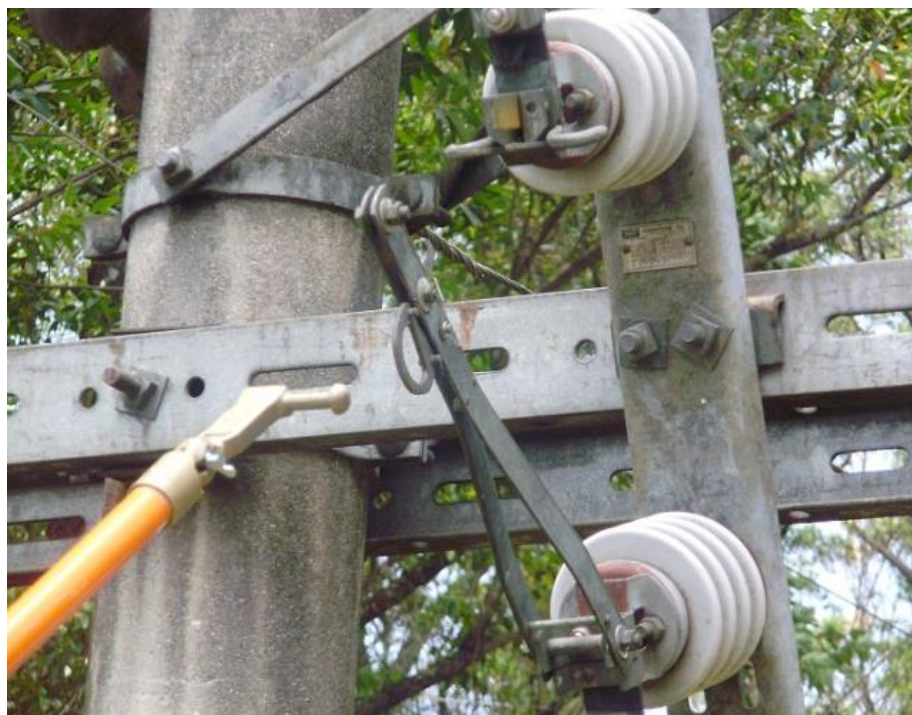
Figura 14: Chave Seccionadora
