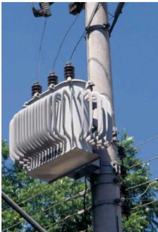
Figura 10: Ligação elétrica de transformador de distribuição
