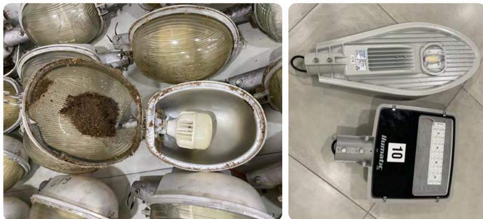
Da esquerda para a direita: figura 12 - Luminárias do parque de IP da Ufac antes do *retrofit* e figura 13 - Luminárias LEDs
